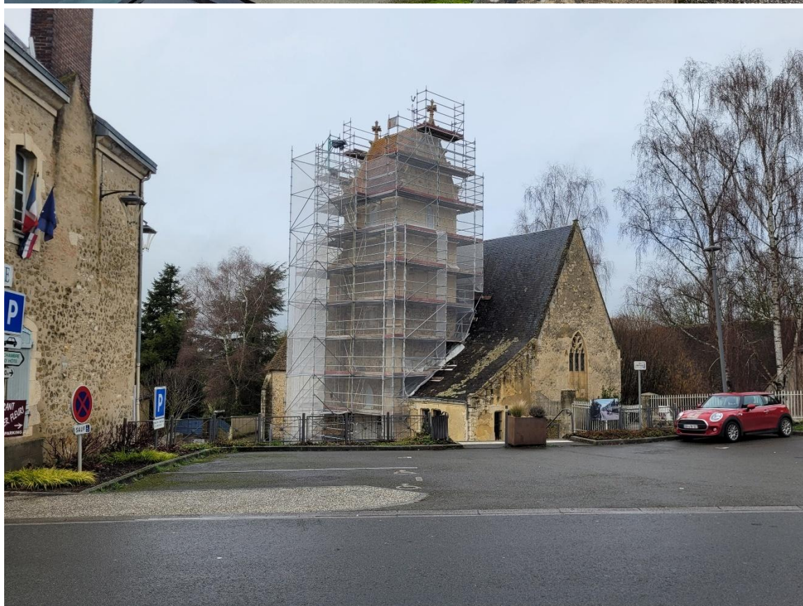
Figure 15 : l'église protégée de Sceaux-sur-Huisne en cours de rénovation, de dimension modeste (Prises de vue : CVE)
