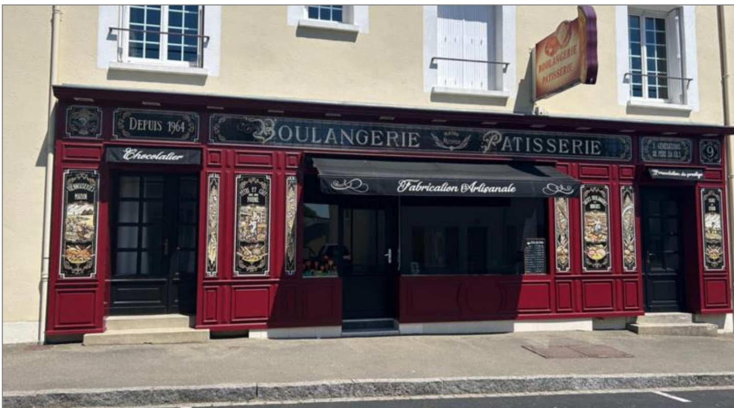
46) Photographie d'une nouvelle très belle enseigne dans le style traditionnel sur Yvré l'Evêque. On peut regretter d'avoir maintenu l'enseigne drapeau qui jure dans l'esthétique et qui n'est pas conforme en raison de sa fixation au niveau des fenêtres
